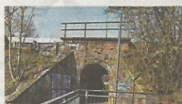
► Unterführung: Die Ortsumgehung muss unter der Bahnlinie Aachen-Mönchengladbach durch. Geschätzte Kosten dafür: 1,7 Millionen Euro.
