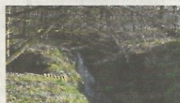
► Überführung: Mit einer Brücke muss der kleine Amstelbach überwunden werden. Das wird aufwendiger als gedacht. Geschätzte Kosten dafür: 2,1 Millionen Euro.
