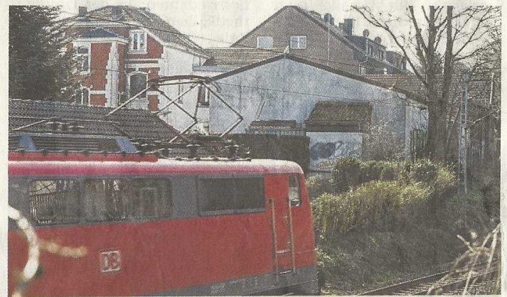
Noch Hinterhofatmosphäre: Unmittelbar neben dem Bezirksamt soll der Bahnhofsteilpunkt gebaut werden.
