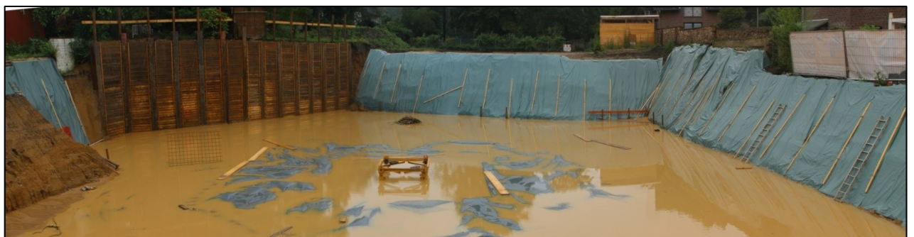
Abbildung: komplett gefülltes Mischwasserbecken nach dem Starkregen vom 14.07.2021
