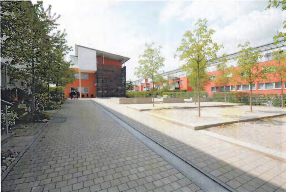
Ableitungsrinne in Gemeinschaftsfläche für mehrere Grundstücke Cluster (Wohngebiet Vimy-Kaserne, Freising)
