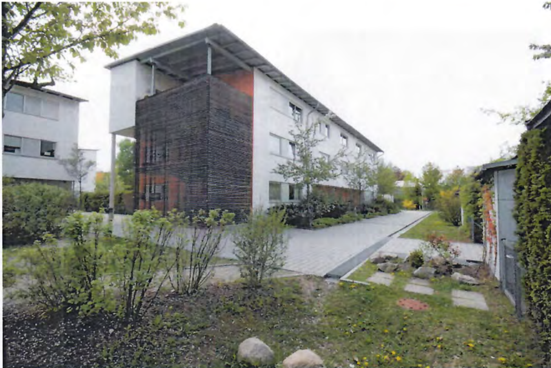
Ableitung von privaten Grundstücken in Grünfuge/ Retentionsmulde (Freising)
